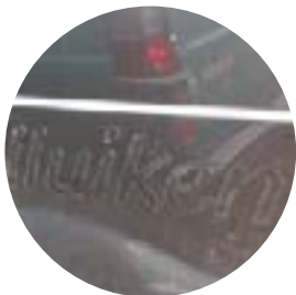
Verkleuring van de lak zichtbaar na verwijderen van reclame
